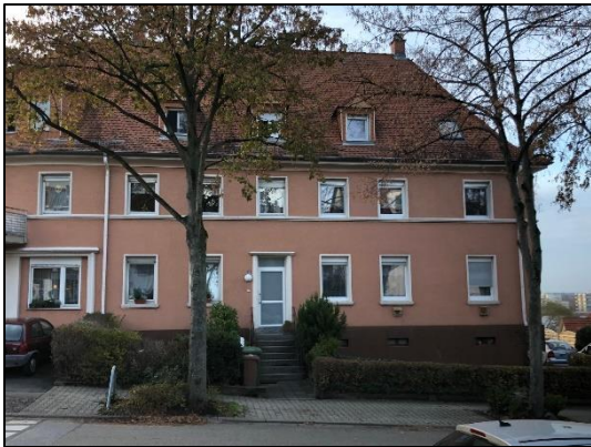
Abb. 33: Horizontale und vertikale Gliederung bei einem traufständigen Gebäude in der Friedrich-Vogler-Straße
