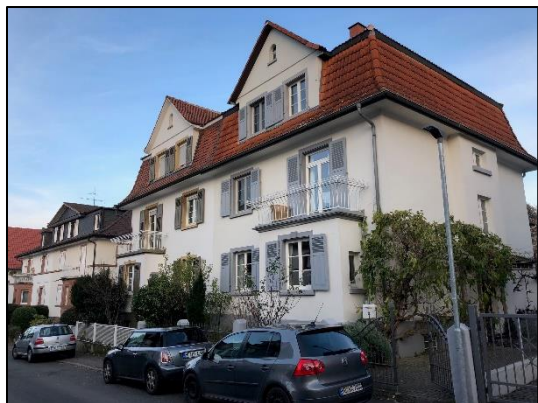
Abb. 13: Ausbau des Dachgeschosses in der Bissingerstraße
