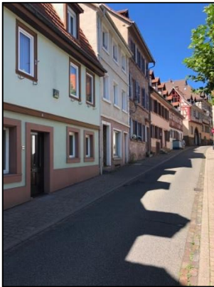
Abb. 7: Traufständige Gebäude in der Mittelgasse
