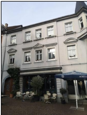
Abb. 38: Gebäude mit Fensterbank- und Gurtgesims
