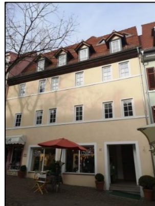
Abb. 39: Gebäude mit Fensterbankgesims
