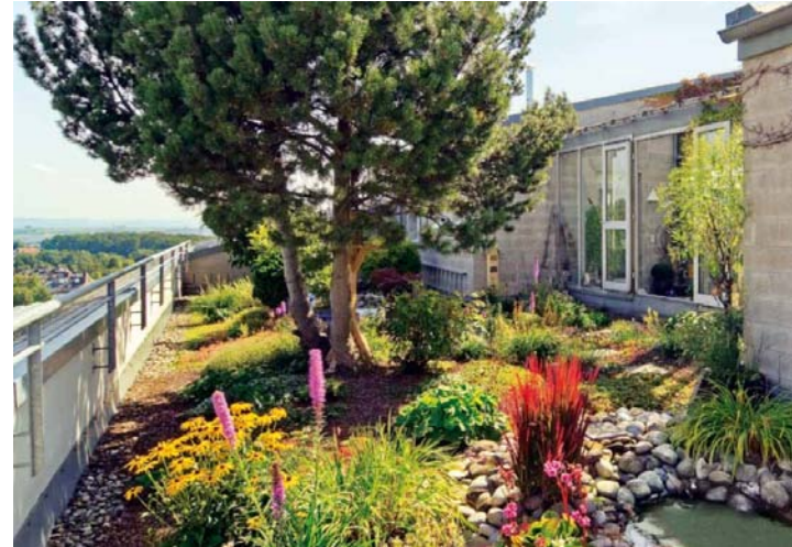
intensiv begrüntes Dach
