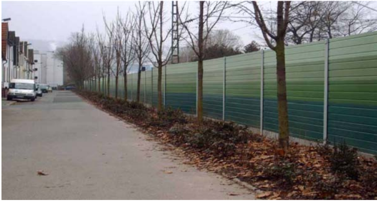
Abbildung 1: Lärmschutzwand entlang der Moselstraße 7
