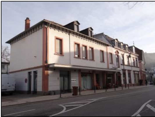
Abb. 22: Horizontale Gliederung bei einem traufständigen Gebäude in der Bahnhofstraße
