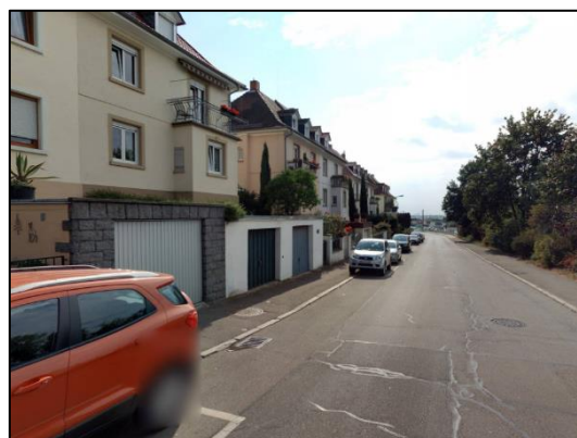
Abb. 13: Aneinandergereihte Garagen als Begrenzung des öffentlichen Straßenraums in der Prankelstraße
