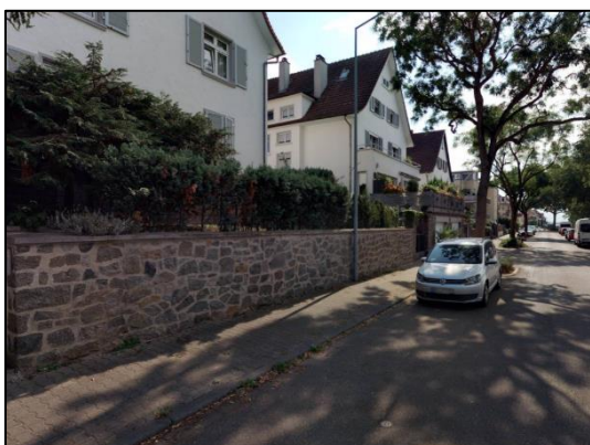
Abb. 12: Über dem Straßenniveau liegende Gärten in der Rosenbrunnenstraße
