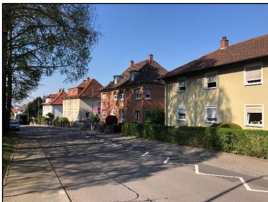
Abb. 8: Traufständige Gebäude in der Prankelstraße
