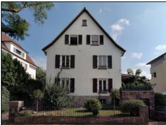
Abb. 33: Horizontale und vertikale Gliederung bei einem giebelständigen Gebäude in der Rosenbrunnenstraße
