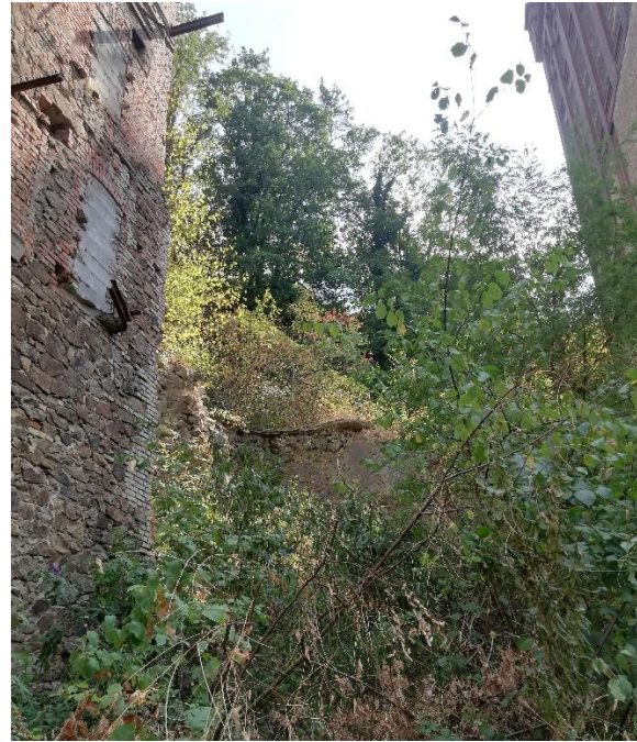
Abbildung 19: Niedrigere Felswand zwischen Siloturm und östlichem Bestandsgebäude (Eigene Aufnahme 19.08.2022)
