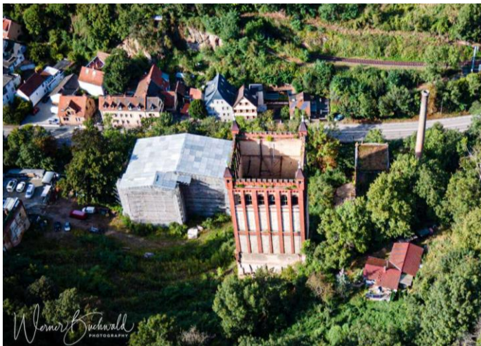
Abbildung 5: Luftbild nach Rückbau von Gebäuteteilen und mit Notüberdachung der Villa aus Richtung Süden, Quelle: Werner Buchwald
