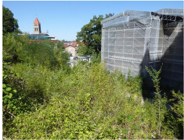
Abbildung 27: Blick nach Nordwesten auf die eingerüstete Villa (Eigene Aufnahme 09.08.2022)
