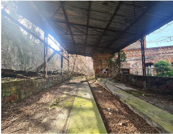
Abbildung 32: Ehemalige Verladehalle im Osten (Eigene Aufnahme 21.03.2022)
