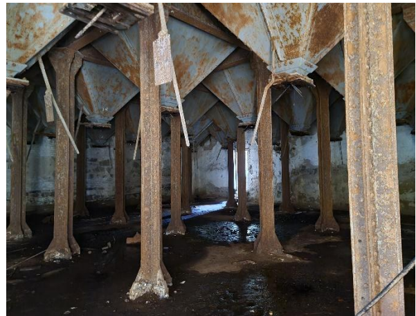
Abbildung 35: Blick ins Innere des Silos (Eigene Aufnahme 21.03.2022)
