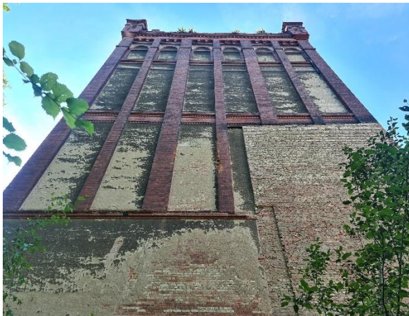
Abbildung 34: Siloturm (Eigene Aufnahme 22.07.2022)
