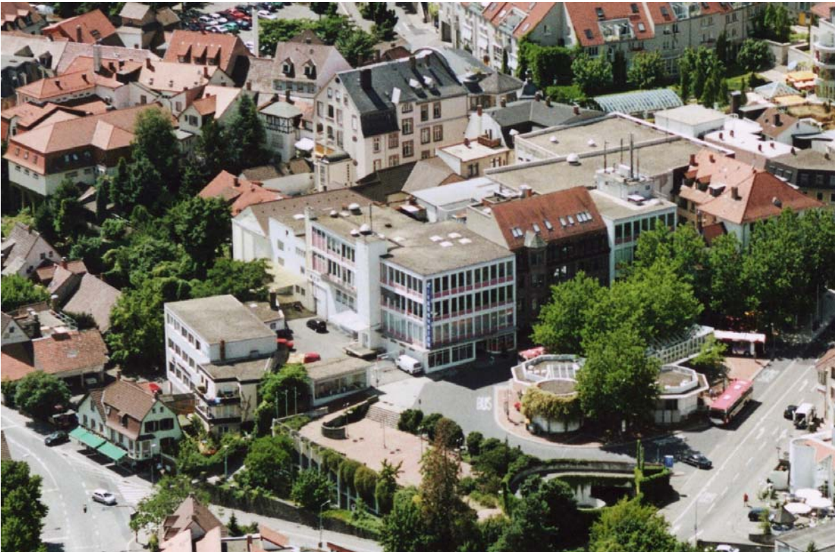
Foto 1: Vor dem Abriss: Blick auf das Plangebiet von Nordosten
