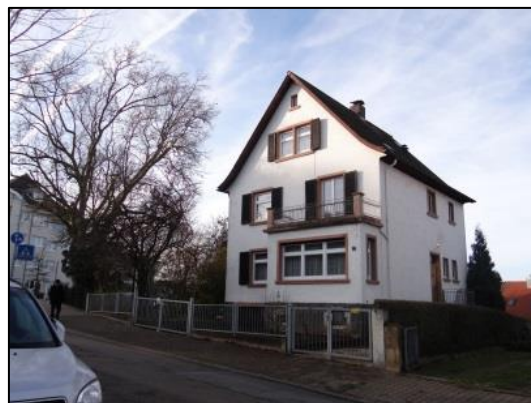
Abb. 8: Giebelständiges Gebäude in der Albert-Ludwig-Grimm-Straße
