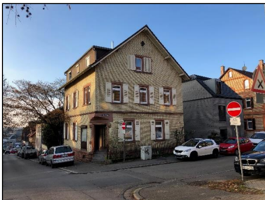
Abb.33: Horizontale und vertikale Gliederung bei einem giebelständigen Gebäude in der Sophienstraße
