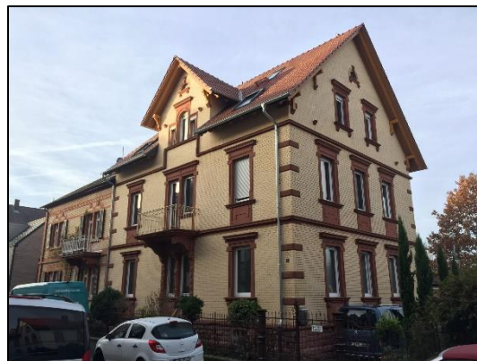
Abb.40: Gebäude mit Gurtgesims
