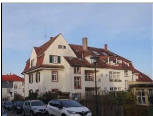
Abb. 22: Mansarddach mit Satteldach
