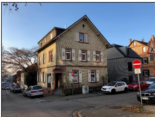
Abb. 41: Faschen und Gesims aus Buntsandstein
