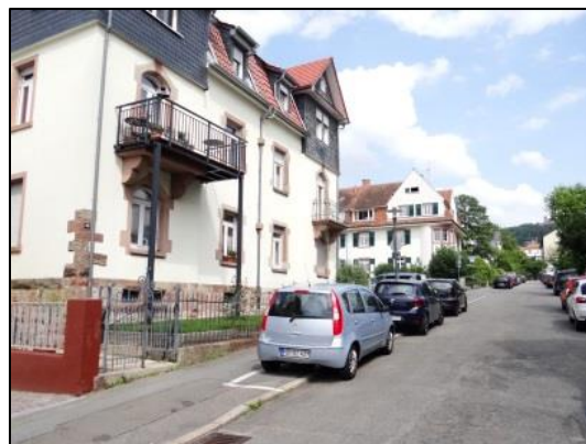
Abb. 42: Sockel aus Bruchstein und Faschen aus Buntsandstein
